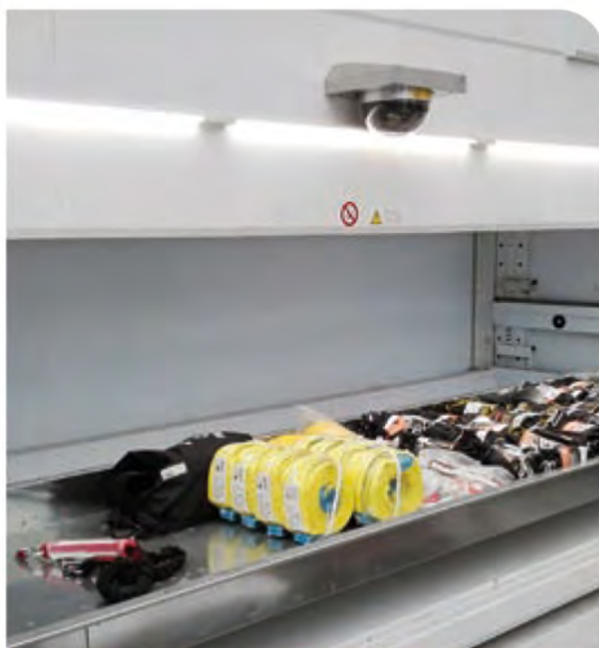
Iluminación LED bahía externa
