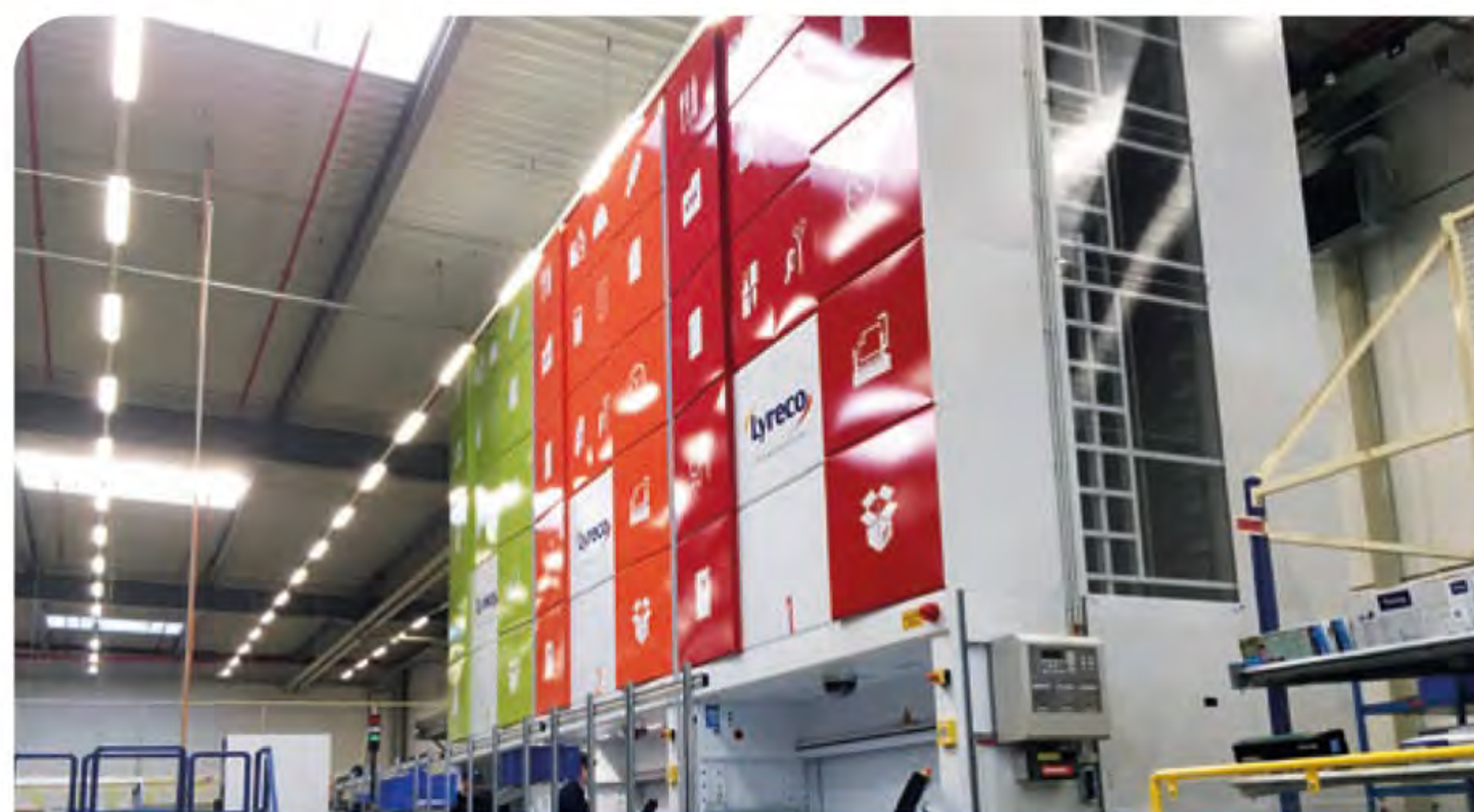
Preparación para instalación de sistema contra incendios
